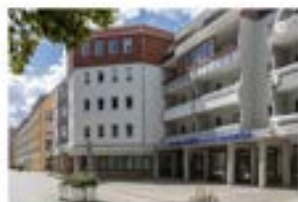
Uni-Gebäude Große Scharrnstraße 23 a (GS)
